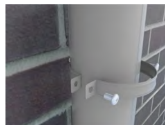
Das Montageblech wird mit der Fallrohrhalterung verschraubt, um das Rohrsystem an der Hauswand zu stabilisieren.
