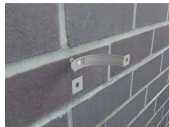
Die Montage der Schelle an der Wand erfolgt mit Hilfe eines Spreizankers.
