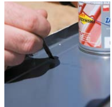
Die Ausbesserungen werden lokal durchgeführt, um nur die beschädigte Plattenoberfläche zu schützen.
