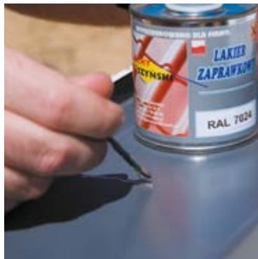
Die zu lackierende Oberfläche sollte sauber und entfettet sein. Wir schützen alle Kratzer und Schürfungen.
