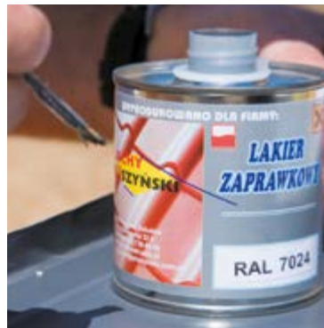
Zu den Ausbesserungen wird eine Ausbesserungsfarbe benutzt, die in der Farbe der Eindeckung erhältlich ist.
