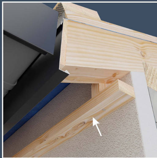
Montage des Befestigungsrahmens für die Laibung.
